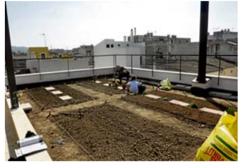
■ Eine Probe ergibt, dass die vulkanisierten „Nähte“ der Kautschukfolie wasserdicht sind. Auf eine Folie zum Wurzelschutz wird Erde geschüttet. Dann werden vier Beete angelegt. F.: SEBASTIÀ BERGA
