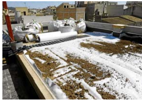
■ Eine Probe ergibt, dass die vulkanisierten „Nähte“ der Kautschukfolie wasserdicht sind. Auf eine Folie zum Wurzelschutz wird Erde geschüttet. Dann werden vier Beete angelegt. F.: SEBASTIÀ BERGA
