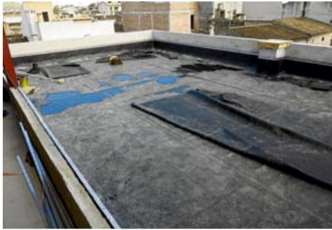
■ Eine Probe ergibt, dass die vulkanisierten „Nähte“ der Kautschukfolie wasserdicht sind. Auf eine Folie zum Wurzelschutz wird Erde geschüttet. Dann werden vier Beete angelegt. F.: SEBASTIÀ BERGA
