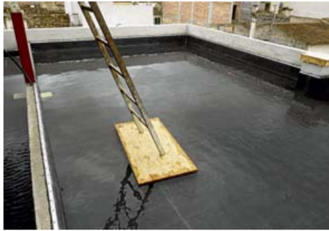
■ Eine Probe ergibt, dass die vulkanisierten „Nähte“ der Kautschukfolie wasserdicht sind. Auf eine Folie zum Wurzelschutz wird Erde geschüttet. Dann werden vier Beete angelegt. F.: SEBASTIÀ BERGA
